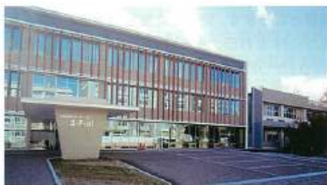
▲附属図書館分館・学生支援棟 (S-Port) 奥は既設図書館
