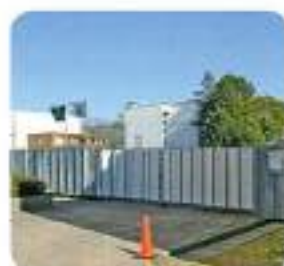
更地の工事現場(2月撮影)
